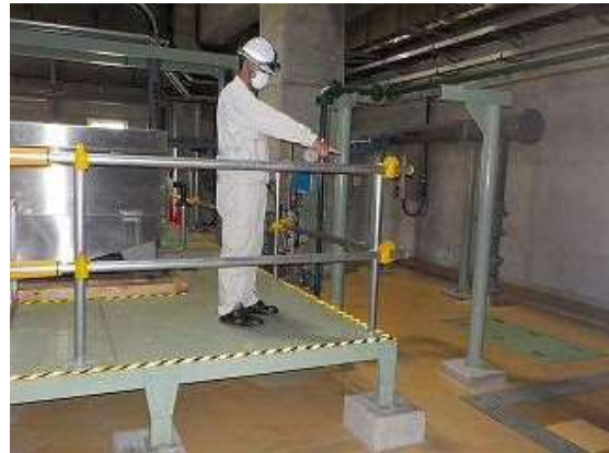
図8 安全対策後（転落防止柵設置）
