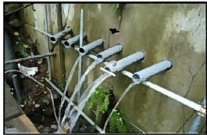
応急②坑内地下水排除工
