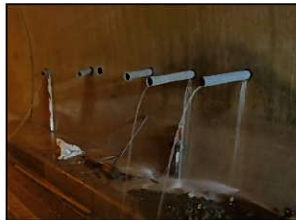
応急②坑内地下水排除工
