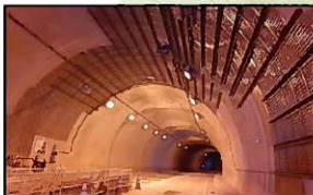
応急③FRPネット等
