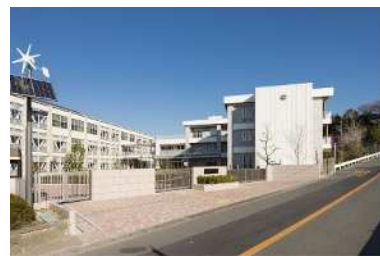
既存ストック活用 (左：旧校舎、右：増築校舎)
