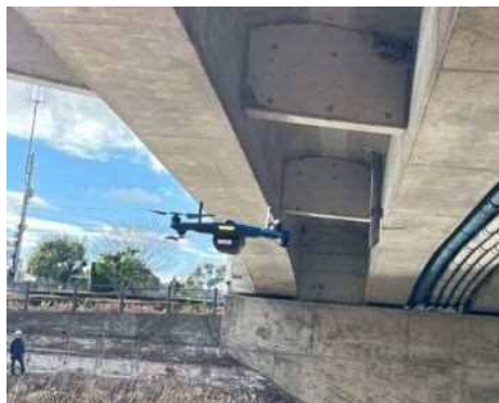
(提供 : 日本航空・KDDIスマートドローン)
