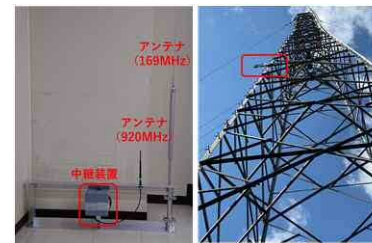
鉄塔に設置した通信中継装置
