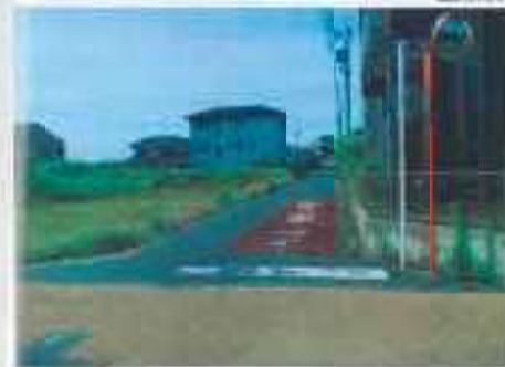
■市道 高塚3号線 (区画6号線) 整備前
