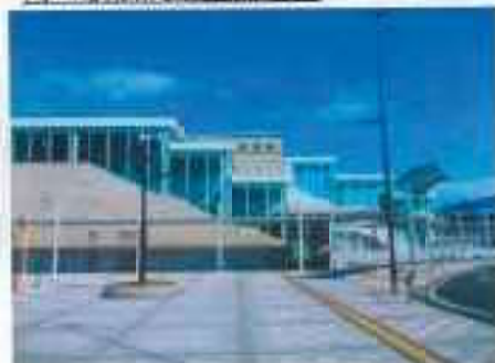
南北自由通路が完成し、駅北側の利便性が向上しました。
