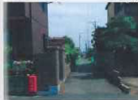
■市道 高塚2号線 (区画5号線) 整備前
