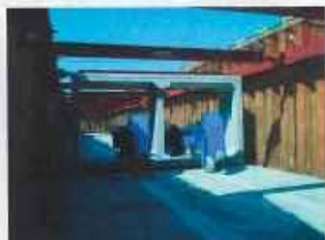
リフトローラー工法による施工
