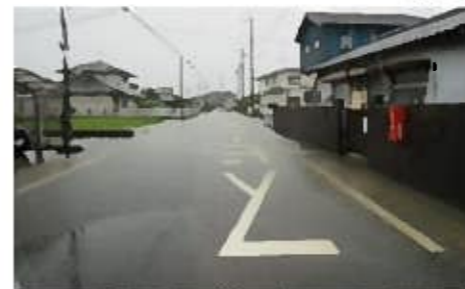
道路冠水(東区天王町) (平成27年9月降雨)
