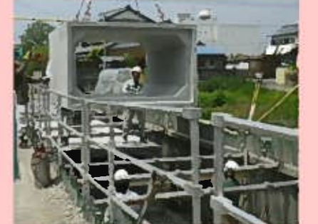
石原4号排水路改修工事
