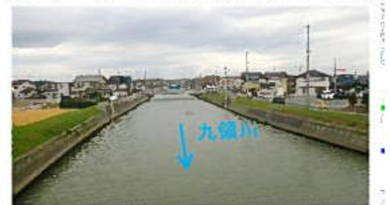
九領川河川改修区間 (志都呂町)
