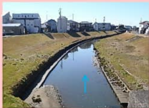
改修済み区間の様子（南区安松町）
