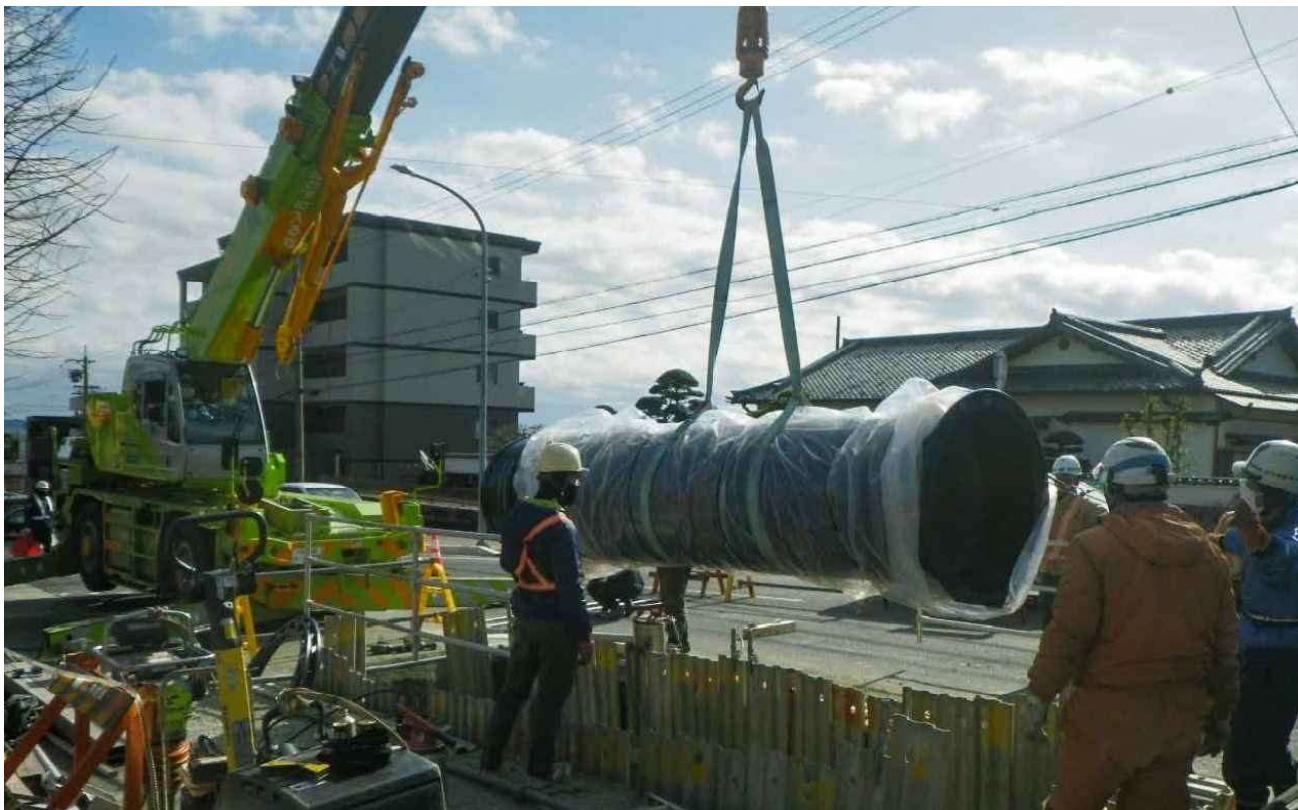
▲ 水道基幹管路耐震化
