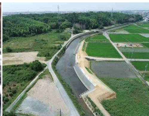
▲ 浸水対策のための河川工事
