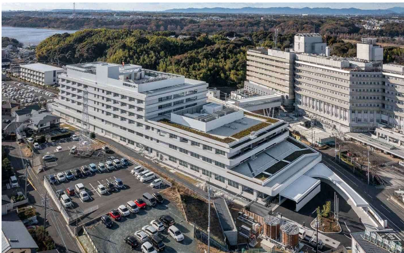
▲ 浜松医療センター新病院棟
