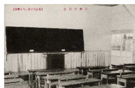
北庄内尋常高等小学校新校舎教室
