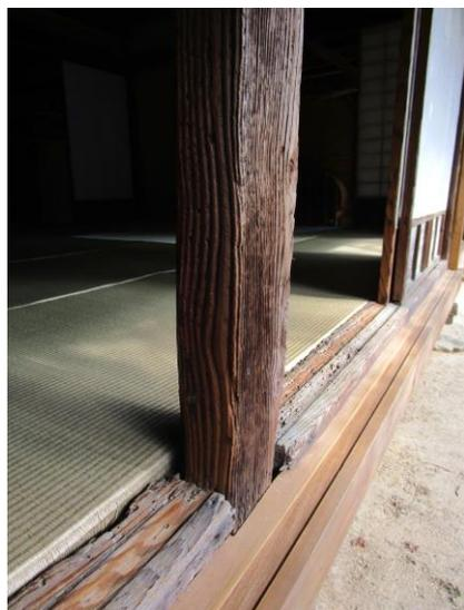
ひとつは、「おい」と呼ばれる座敷の南側の柱です。通常の柱の断面は正方形ですが、この柱は、棟方向が約一三センチメートルなのに、梁方向は約一〇センチメートルで、正方形ではありません。
