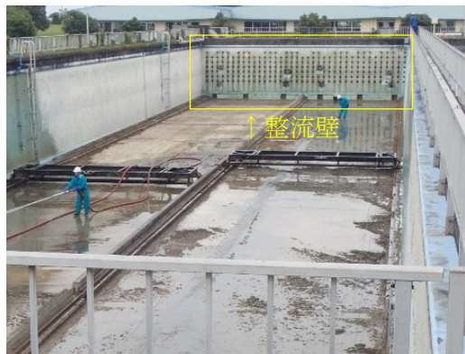
〔参考〕水を抜いた沈澱池
