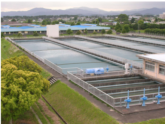
[参考] 浄水施設（沈澱池）
