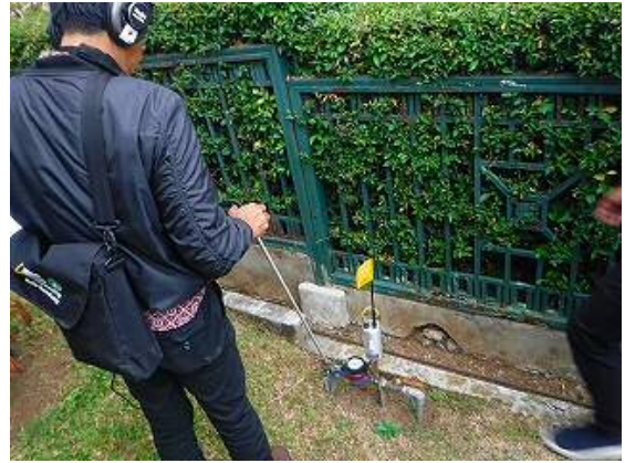
【漏水調査風景】
