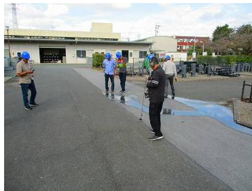
【漏水調査実演】
