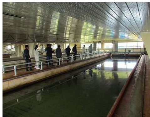
【大原浄水場視察】
