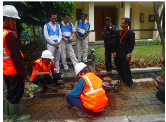
【修繕作業風景】
