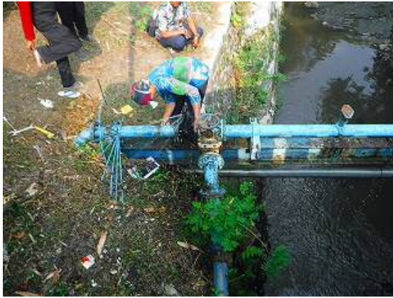
【漏水修繕風景】
