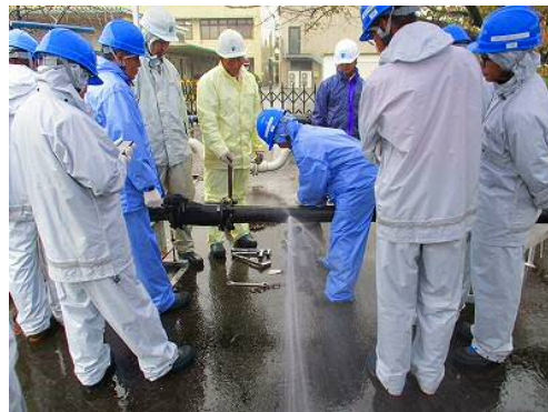
【漏水修繕実演】
