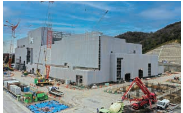
天竜区青谷に建設中の新清掃工場(5年2月末現在)
