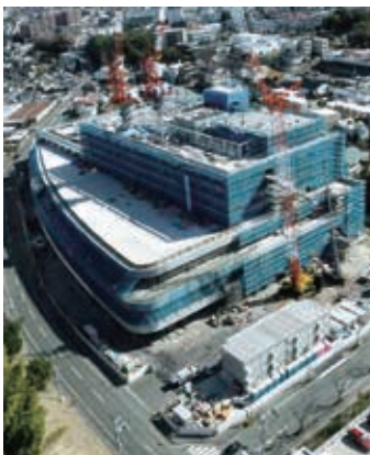
建設中の浜松医療センター新病院棟 (6年1月開院予定)
