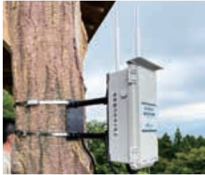
森林組合おおいがわにおけるLPWA機器の設置事例
