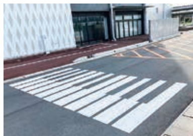
市民音楽ホールに設置した鍵盤型横断歩道
