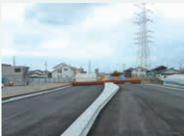
整備が進む市道有玉南初生線バイパス
