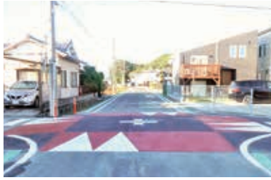
交差点内ハンプ(通行する自動車の速度を抑制するため凸状に盛り上げて施工されている)
