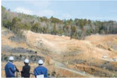
造成が進む新清掃工場建設予定地
