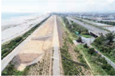
防潮堤(舞阪工区)
