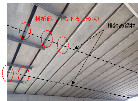
写真 2.1 横桁部の打ち下ろしの例
