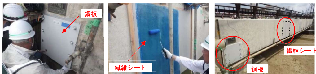
写真 23 横締め PC 鋼材の突出防止対策
