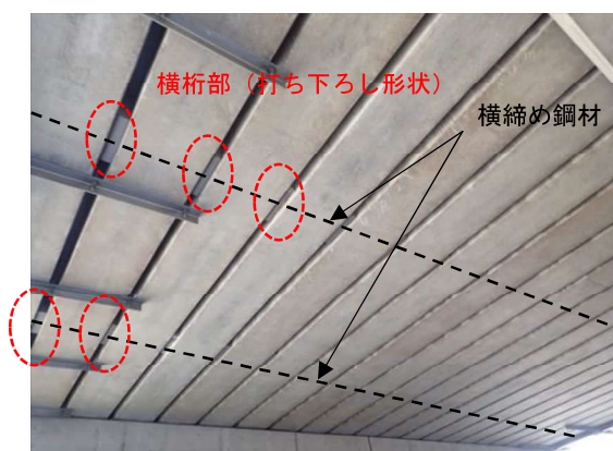
写真 2.1 横桁部の打ち下ろしの例
