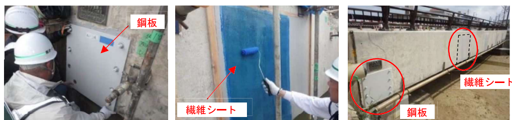
写真 23 横締め PC 鋼材の突出防止対策
