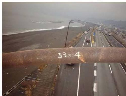
図2 支柱本体の腐食事例
