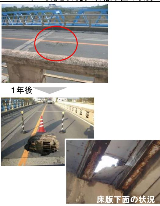
床版下面に設置された補強材等に広がりを有する腐食が生じている場合、コンクリート内部での滯水により既にコンクリートの劣化が進展し危険な状態となっていることがある。
