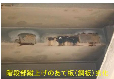
階段部蹴上げのあて板(鋼板)劣化
