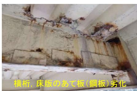
横桁、床版のあて板(鋼板)劣化
