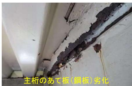
主桁のあて板(鋼板)劣化
