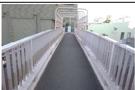
アスファルト舗装表面のひびわれが軽微であったとしても、雨水等が浸入し床版上面に滯水が生じることによって、床版デッキプレート上面に腐食や欠損が生じている場合がある。床版デッキプレート裏面（下面）側でも腐食が見られる場合には、著しく腐食が進行している可能性がある。
