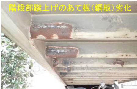
階段部蹴上げのあて板(鋼板)劣化
