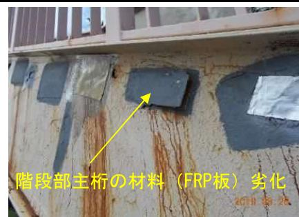
階段部主桁の材料 (FRP板) 劣化
