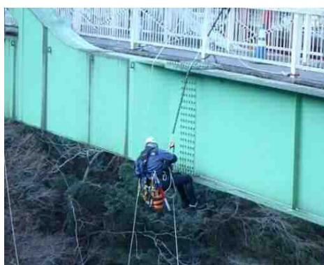
写真 2-5 ロープを用いた近接目視点検
