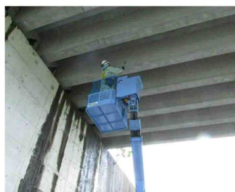
写真 2-3 高所作業車による近接目視点検
