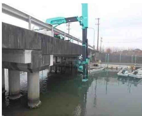
写真 2-2 橋梁点検車による近接目視点検
