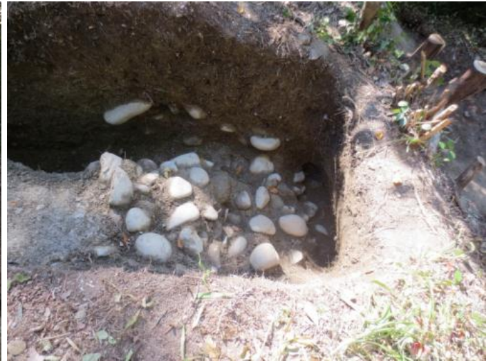
西曲輪西面石垣の裏込石の検出状況
