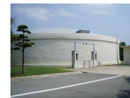
耐震補強した配水池
