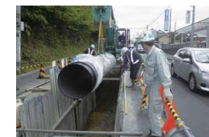
基幹管路の耐震化（布設替え）
