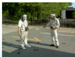
漏水探査の様子
