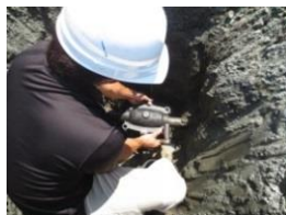
漏水修繕の様子
