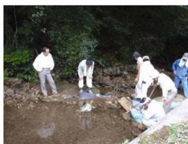
水田への配水のための堰づくり
