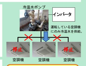
インバータにより、ポンプで送る 冷温水の量を必要最小限にする ことで、ポンプの電気使用量を 80%以上削減できた。
