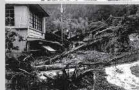
土石流による被害の様子（昭和44年、旧春野町若身）
