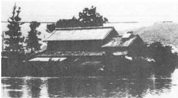
浸水の様子 (旧引佐町谷津橋付近,1974年)
