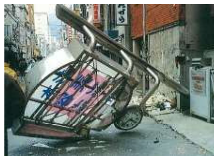
屋外物の落下による被害例
