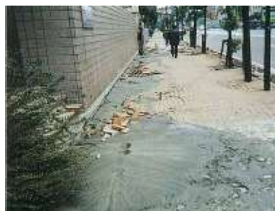
液状化による被害例
