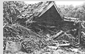
堀谷地内のがけ崩れによる被害の様子
