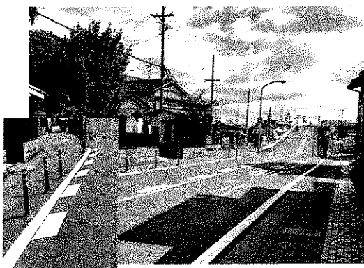
交通安全対策 ラバーボール及び車道内に破線ラインの設置
