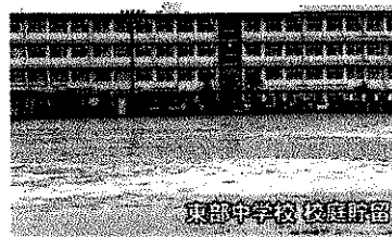
令和5年6月豪雨と安間川浸水被害
