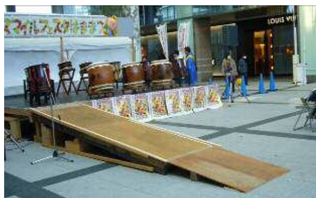
《車いす用スロープ》
