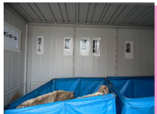
きれいに管理された保管庫内の様子
