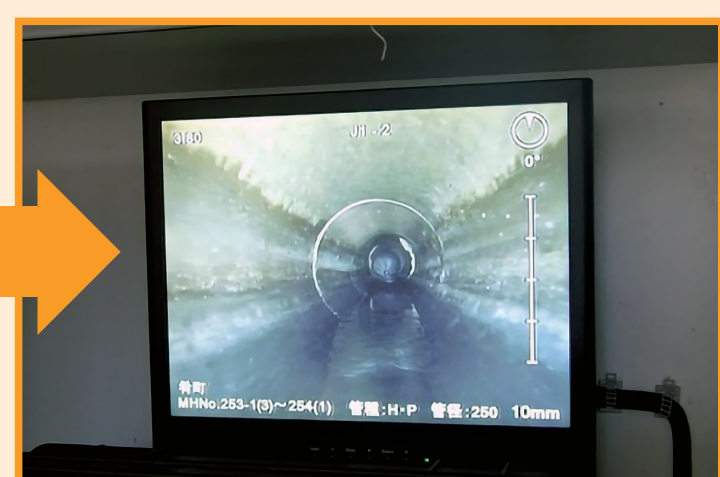
ロボットが撮影した下水道管の中の状況
