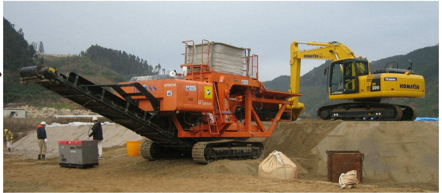
材料搬入・混合工(水+セメント+CSG母材)
