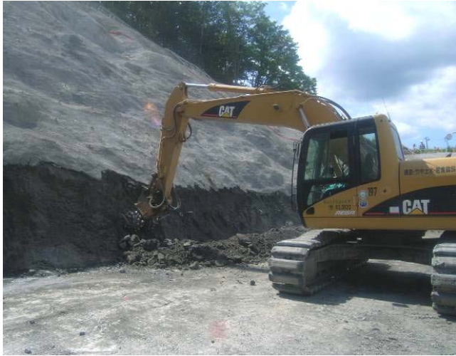
CSG母材掘削工
