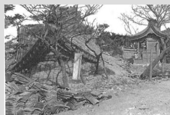
六所神社社殿の倒壊(中野町)
