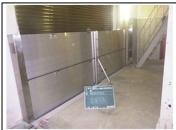
図 下水道施設の耐水化
