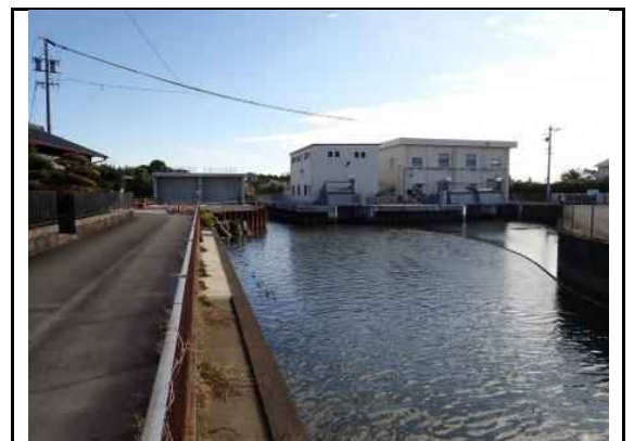
図 排水機場（高塚川）
