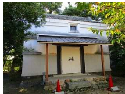
▲中村家住宅土蔵の改修
