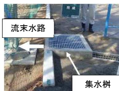
雨水流出抑制施設の例
