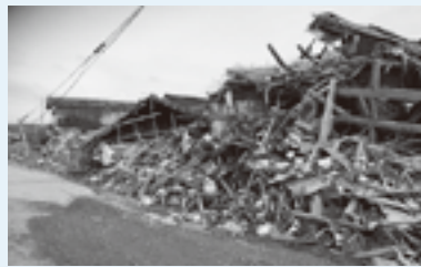
▲令和6年能登半島地震で倒壊した家屋
