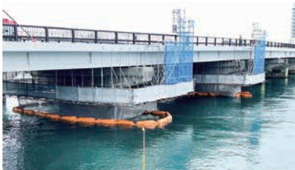
橋脚巻立て工による中浜名橋の耐震補強工事(中央区舞阪町)
