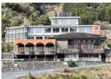
建設当初「山里にモダンな新校舎」といわれた中山間地域の周辺にある旧滝沢小学校
