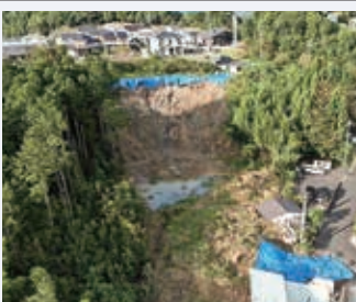
天竜区緑恵台で発生した盛土による土砂崩れ
