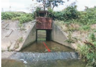
改修が予定される通称御園川の樋門(浜名区三ヶ日町)
