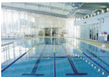
プール天井部分の鉄骨構造体部などの劣化により閉館した浜北温水プール
