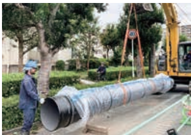
震災発生時にできるだけ早く水道施設を応急復旧させるため耐震管への布設替え工事
