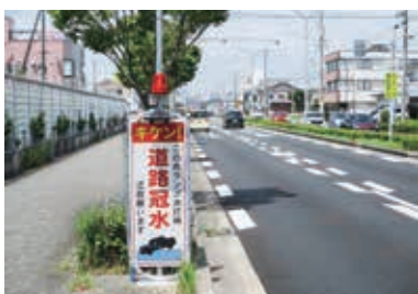
ランプで冠水を知らせる道路冠水センサーシステム
