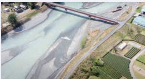
天竜川水系におけるドローン実証実験(空撮による河川点検)
