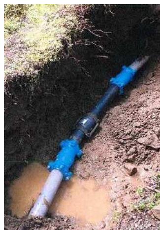
飲料水供給施設の管路修繕(完成)
