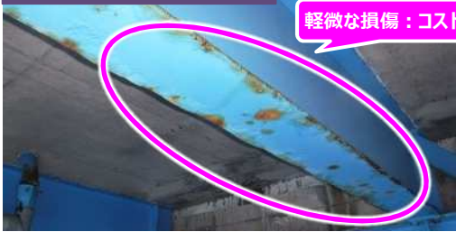
健全性Ⅱの事例（橋梁）
