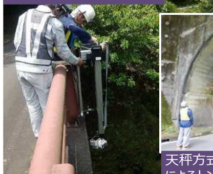
ロボットカメラによる橋梁点検
