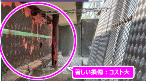
健全性Ⅲの事例（橋梁）
