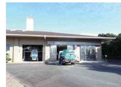
東部衛生工場（し尿処理施設）
