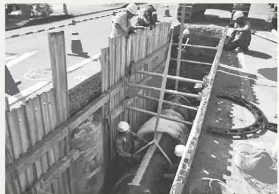
▲重要な管路の耐震化工事(水道事業)
