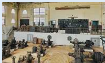
② 旧住吉浄水場 ポンプ室の 3Dモデル作成
