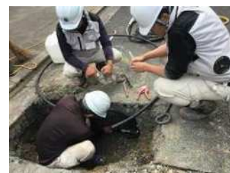
OJT（管路修繕）
