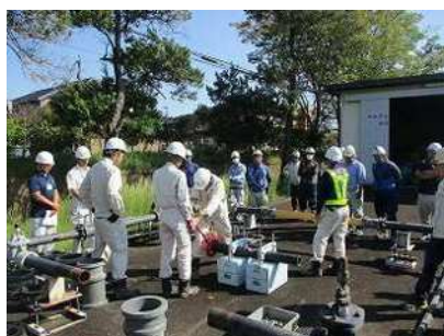
漏水修繕研修〔住吉庁舎の研修施設〕
