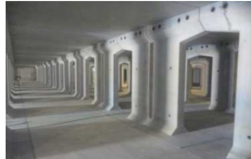
公園の地下に整備した雨水貯留施設 (2019 年度 供用開始) ※写真は建設当時
