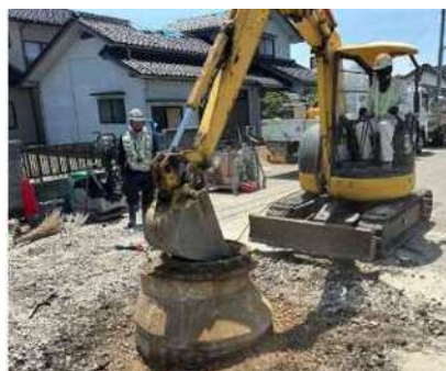
令和6年能登半島地震における 本市の事業者による復旧活動 （浮上したマンホールの撤去）〔石川県珠洲市〕
