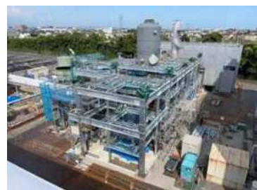
エネルギー効率の高い汚泥焼却炉への更新工事 (2022～2024年度) [中部浄化センター]
