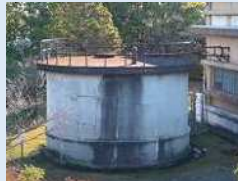
旧住吉浄水場 直送ポンプ井
