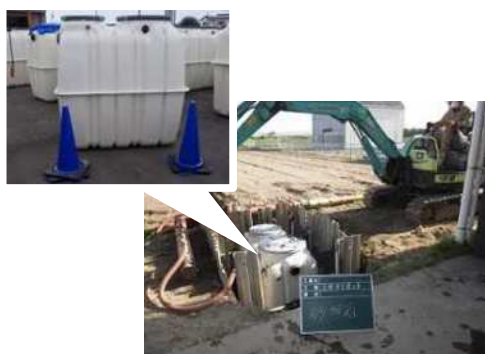
合併処理浄化槽の設置
