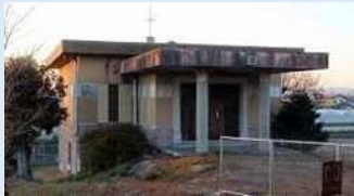
旧常光水源 地ポンプ室
