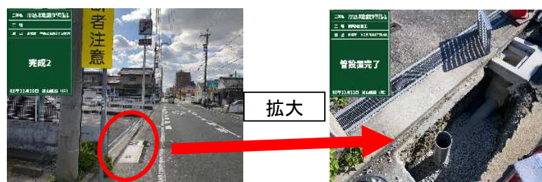
【雨水浸透井設置工事】
