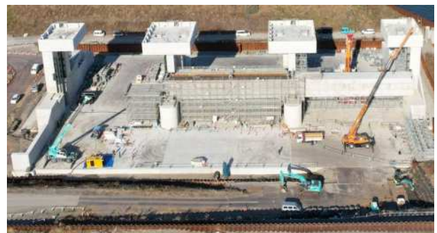
水門整備工事の様子(令和7年1月)
