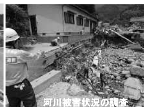
河川被害状況の調査
