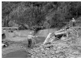
流出した橋の被災状況調査
