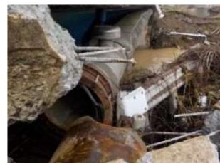
地震の影響で破損した水道管路
