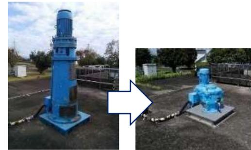
小型でエネルギー効率の高い急速攪拌機への更新（令和2年度）[大原浄水場]
