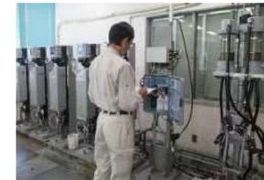
水処理工程における水質監視用計器の点検
