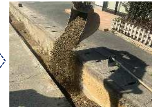
浄水発生土を有効利用した改良土 (水道管工事の埋め戻し材)
