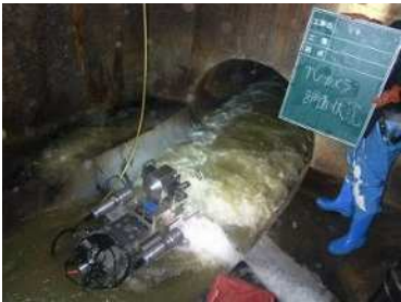
TVカメラ車による下水道管路の点検・調査
