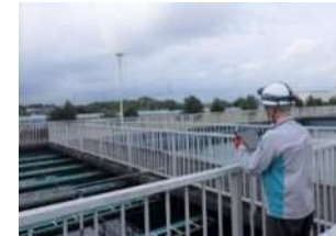
民間事業者による運転管理 〔大原浄水場：沈殿池〕
