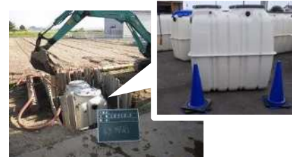
合併処理浄化槽の設置
