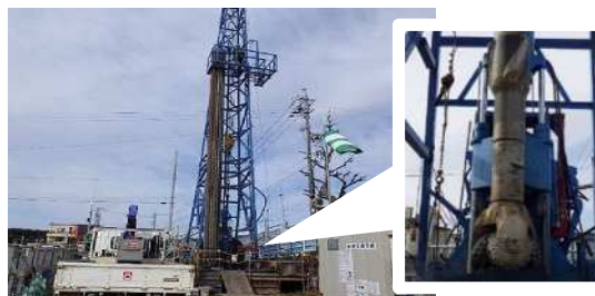
新規井戸水源施設の整備に向けた試験掘削工事 （令和3年度）[中央区半田町]
