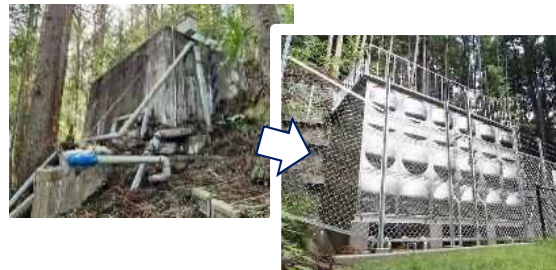
更新により耐震化した中山間地域の配水池（令和5年度）
