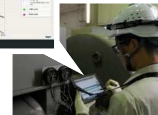
施設情報システムによる設備の状態把握 [中部浄化センター]
