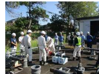
本市が開催した民間事業者を対象とした漏水修繕研修【住吉庁舎の研修施設】
