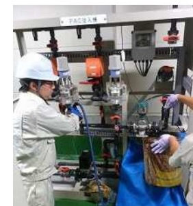
薬品注入機の修繕 [常光浄水場]
