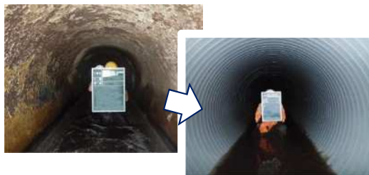
既存管内面に新管を構築する管更生による下水道管路の耐震化
