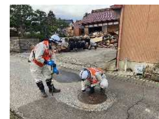
令和6年能登半島地震における応援活動 〈下水道：復旧活動〉[石川県珠洲市]
