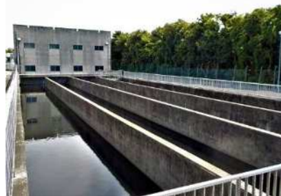
中部浄化センターの運用開始当時から稼働している塩素混和池
