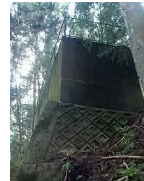
耐震化予定の中山間地域の配水池
