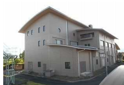
耐震化予定の汚泥処理棟（左）と最終沈殿池（右） [細江浄化センター]
