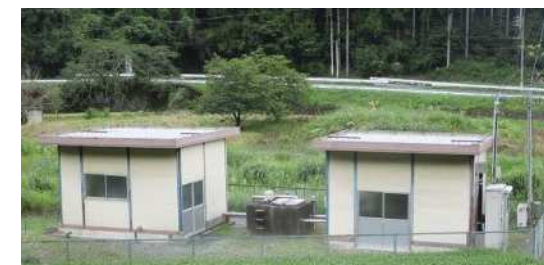
渇水対策のため、水源施設の整備や水融通などを 検討している中山間地域の浄水場
