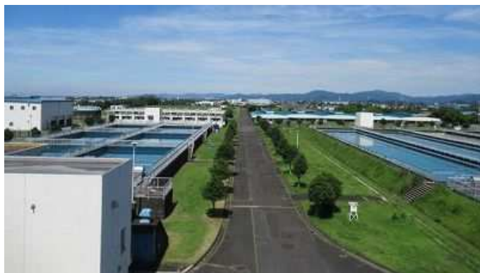
運用開始から54年が経過した大原浄水場 [中央区大原町]
