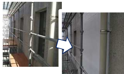
開口部閉塞によるポンプ場の耐震化（令和2年度）[中田島団地雨水ポンプ場]
