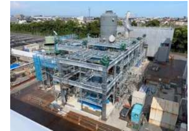
エネルギー効率の高い汚泥焼却炉への更新工事 （令和2～6年度）〔中部浄化センター〕
