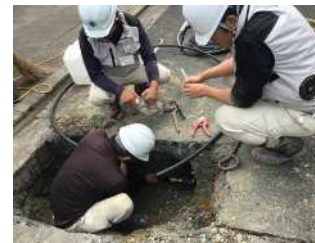
実地研修（管路修繕）
